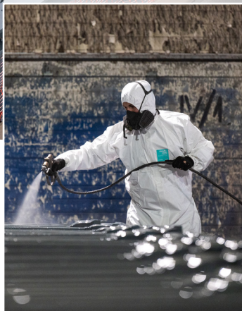
Lánchíd acélszerkezetek üzemi korrózióvédelme csarnokban
