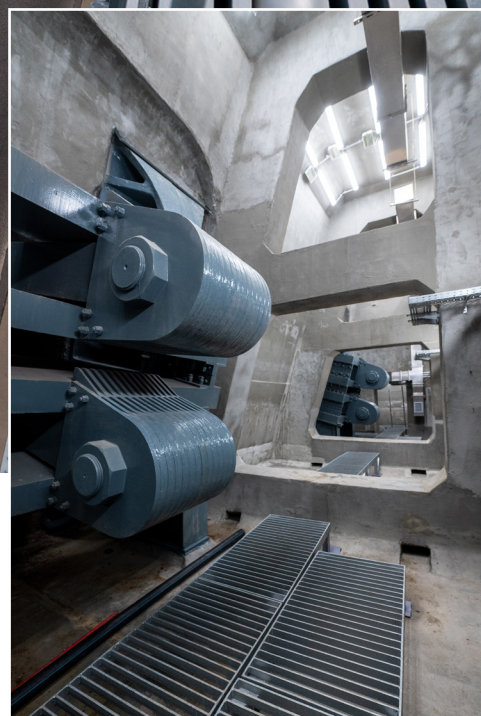
Lánchíd belső szerkezetének korrózióvédelme
