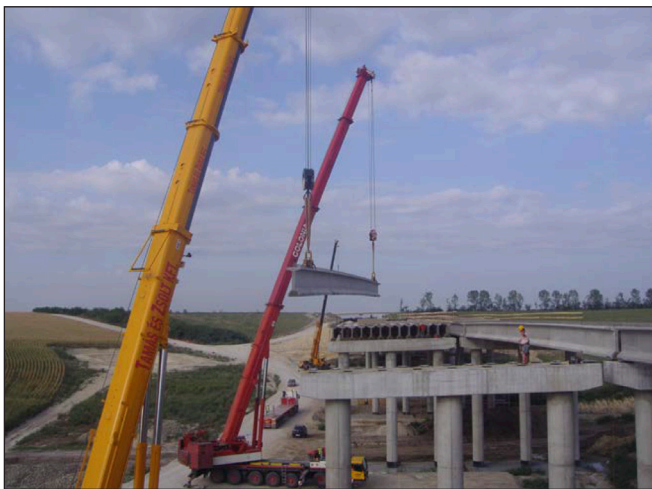
3. ábra: Völgyhíd építése az M6 autópályán
