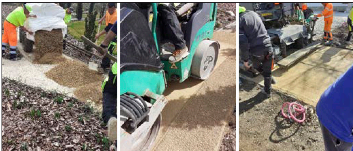
3. ábra: Cementmentes út- és járdaburkolat készítése hengerléssel és finiserrel
